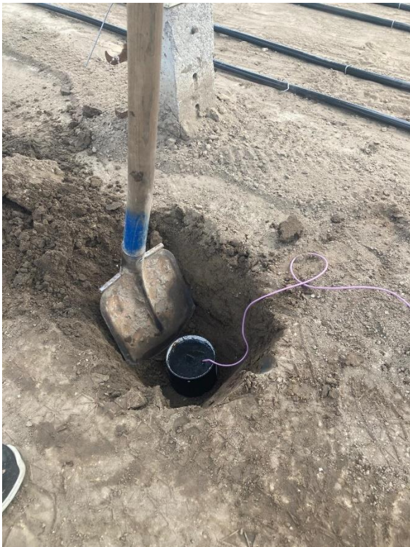
Afbeelding 2: Sensor onder de vloestofdichte laag
