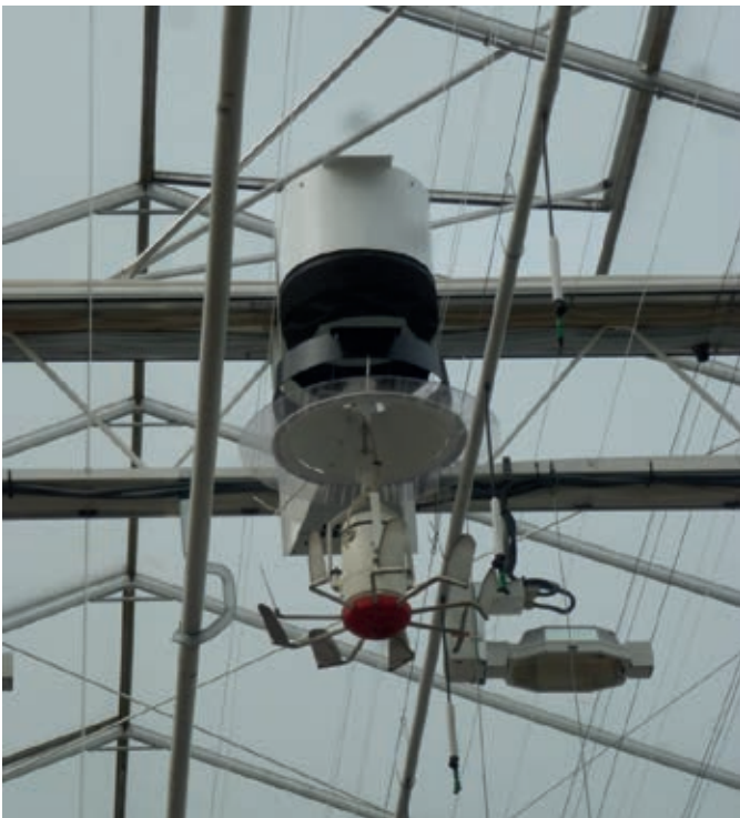
Figuur 9 Ventilation Jet met aanzuigventilator (boven) en nivolator (onder).
