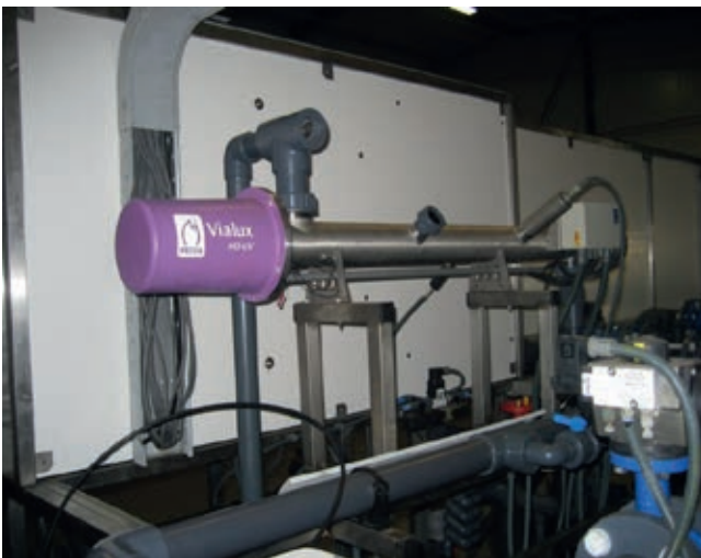
Beelden watersysteem (UV-ontsmetter en mestvoorraadbakken).
