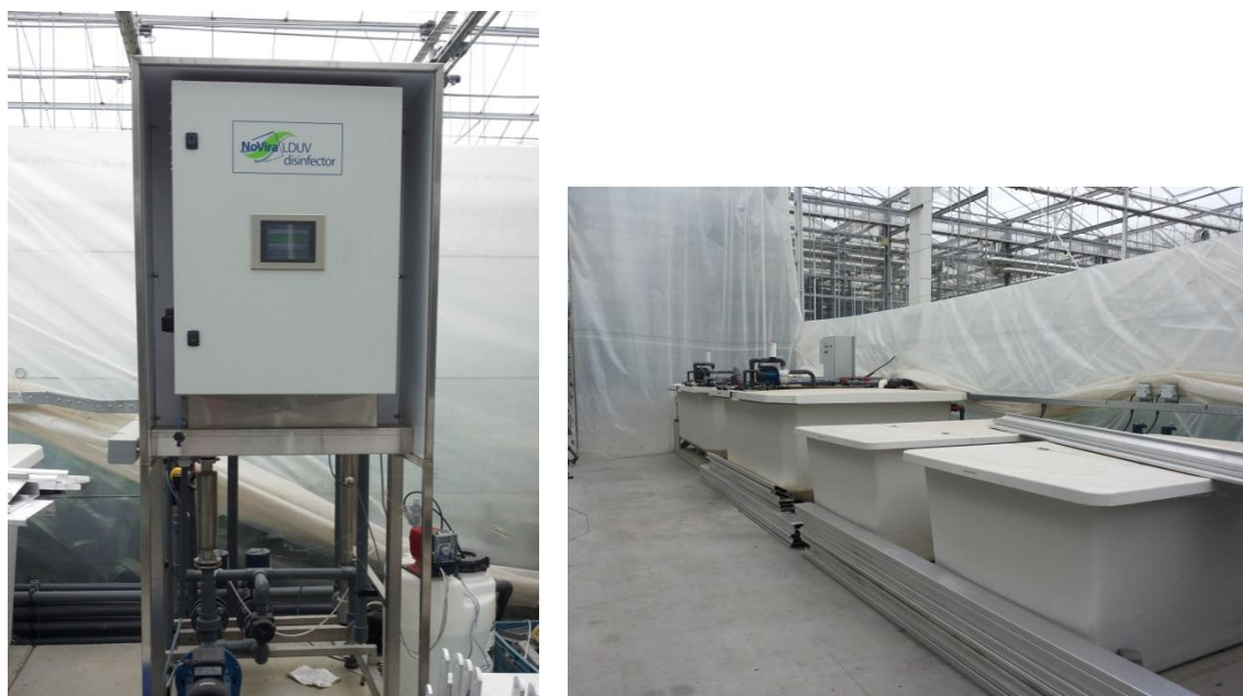
Foto 1: Geïnstalleerde UV-ontsmetter (links) en extra geïnstalleerde vuil water silo's, schoon water silo's en dagvoorraadsilo's (boven) voor de proef met hergebruik van drainwater bij amaryllis.
