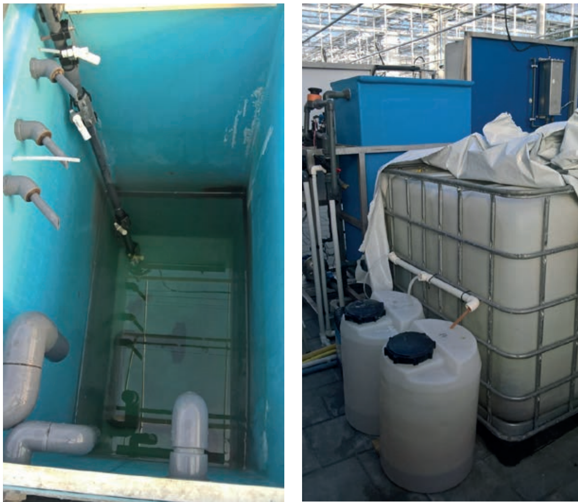
Figuur 1 De mengbak van de afdeling van 120 \text{ m}^2 . Links, beeld over de mengbak. Rechts, beeld van de mengbak, de vaten voor de geconcentreerde voedingsoplossing en de verzamelbuffer voor de afvoer (vuil drainwater).
