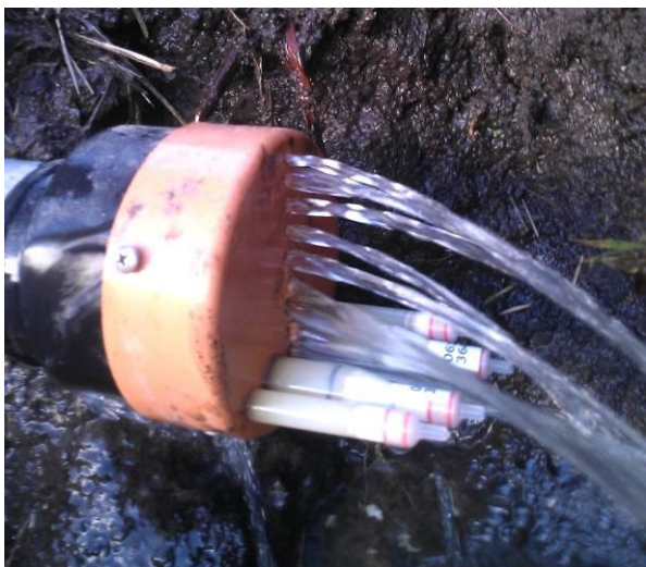
Figuur 4.17: Flow-Cap Zeewolde op 5 februari 2013.
