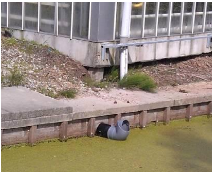
Figuur 3.6: Installatie van een prototype met 90 graden bocht aan het lozingspunt van een kas met grondgebonden chrysantenteelt in het Land van Maas en Waal.
