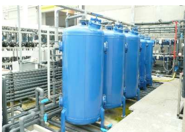
Figuur 3. Zandfilter/multimediafilter (links), SAF-filter (midden) en doekfilter (rechts) hebben van links naar rechts een afnemende hoeveelheid spoelwater
